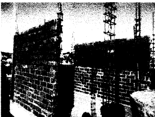
Foto 47 y 48: Colocación de ladrillo de soga tipo kk IV; Instalaciones W.EE y II.SS. PUENTE DE ACCESO, MUJELLE, MZ 17, OCTOPES SA
