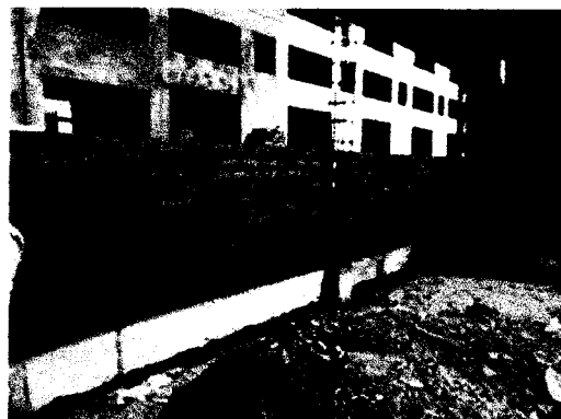
Foto 31 y 32: Levantamiento de muro de saga con ladrillo kk tipo IV. ZONA DE PTAR.
