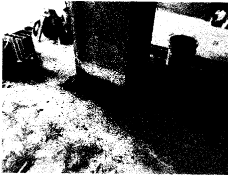
Foto 05 y 06: Contra sócalo sanitario H=0.10m, en muros y columnas interiores. ZONA DE TAREAS PREVIAS
