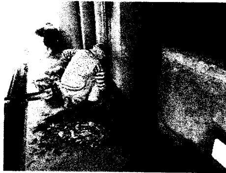
Foto 03 y 04: Tarrajeo de muros interior y contra sócalo sanitario de H=0.10. ZONA DE TAREAS PREVIAS
