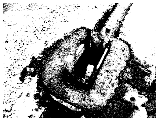
Foto 39 y 40: Instalación de tuberías de 2", salidas para desagüe doméstico y industrial. ZONA PATIO Y SERVICIOS
