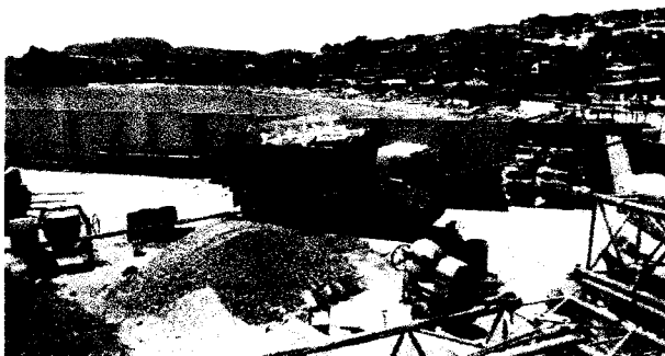
Foto 53 y 54: Acarreo y eliminación de losas de concreto armado de muelle antiguo. ADICIONAL N°01 - MUELLE.
