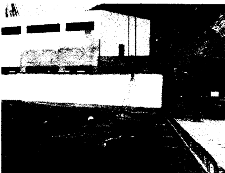
Foto 55 y 56: Acarreo y eliminación de losas de concreto armado de muelle antiguo. ADICIONAL N°01 - MUELLE.
