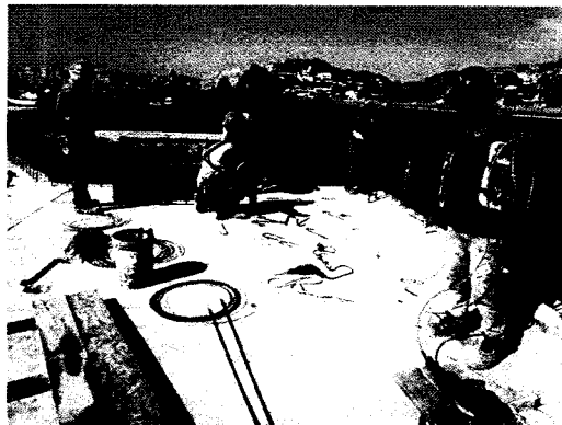
Fotografía N°01: trazo de caseta de bombeo.
