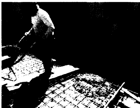
Foto 45 y 46: Concreto f_c = 315 \text{ kg/cm}^2 ; en losas (4.00m x 4.00m x 0.22m) del patio. PATIO DE MANIOBRAS
