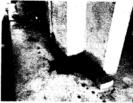
Foto 03 y 04: Tarrajeo de muros interior y contra sócalo sanitario de H=0.10. ZONA DE TAREAS PREVIAS
