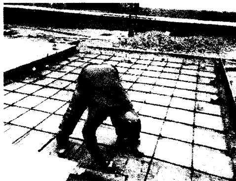
Foto 43 y 44: Acero de refuerzo f_y = 4200 \text{ kg/cm}^2 ; y encofrado en losas del patio. PATIO DE MANIOBRAS
