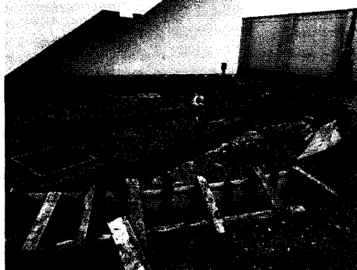
Fotografía N°05: encofrado de veredas en área de servicios.
