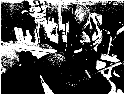
Foto 51 y 52: Concreto f'c=315 kg/cm 2 y acero f'y=4200 kg/cm 2 en sobrecimiento. PUENTE DE ACCESO MUELLE
