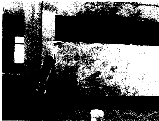
Foto 27 y 28: Pintado de muros, columnas, vigas y derrames con imprimante. EXTERIOR ZONA DE TAREAS PREVIAS
