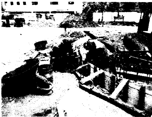
Foto 37 y 38: Concreto f'c=315 kg/cm 2 , y encofrado de veredas y sardinel. ZONA DE PATIO DE MANIOBRAS
